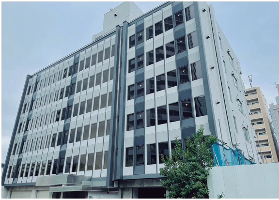
フルリノベーションで生まれ変わった本社社屋
