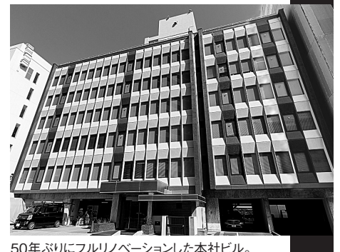
50年ぶりにフルリノベーションした本社ビル。
